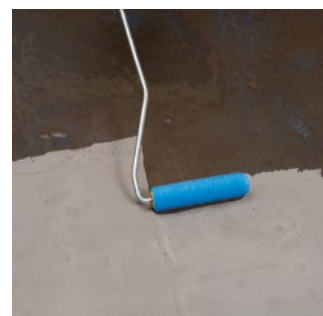
2. Pe suporturile absorbante se aplică uniform Amorsa D7
