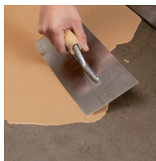
3. Aplicarea Șapei autonivelante rapide SL 52 într-un strat, pe suportul amorsat în prealabil.
