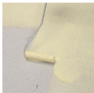
1. Pe suporturile neabsorbante se aplică uniform Amorsa rapidă D4
