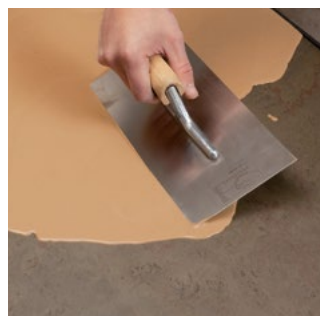
3. Aplicarea Șapei autonivelante rapide SL 52 într-un strat, pe suportul amorsat în prealabil.
