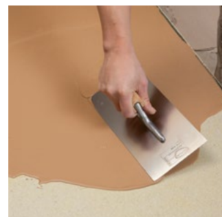
3. Aplicarea Șapei autonivelante rapide SL 52 într-un strat, pe suportul amorsat în prealabil.
