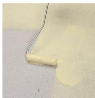
1. Pe suporturile neabsorbante se aplică uniform Amorsa rapidă D4
