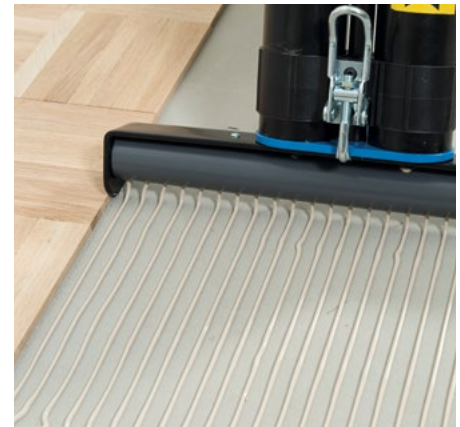
Peretele sau muchia parchetului servesc ca reper lateral de poziționare a piesei de evacuare.
