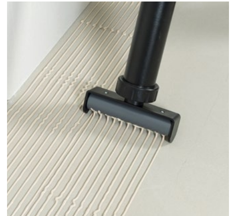
Dispozitivul pentru aplicarea adezivilor silanici X-Bond se așează pe stratul suport, iar distribuția adezivului se face uniform.
