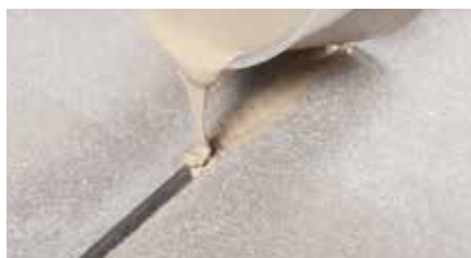
Etanșant rosturi prin turnare PU 50 Elastic Vergussmasse PU 50
