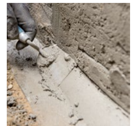
În zonele de racord fundației/perete se realizează scafe tot cu mortarele Murexin din gama Repol .
