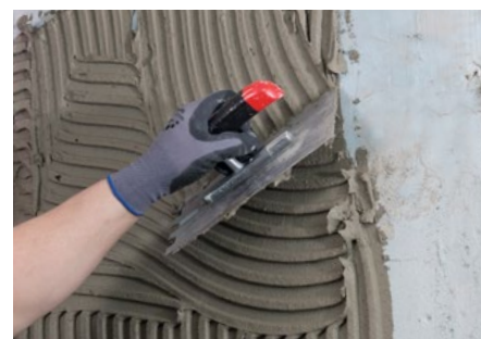
aplicarea hidroizolației cu șpaclul dințat
