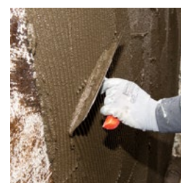
aplicare hidroizolație bituminoasă
