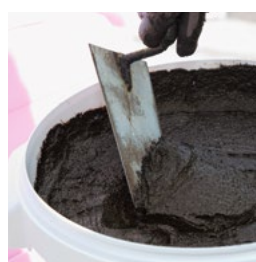
după uscare se realizează lipirea plăcilor termoizolante
