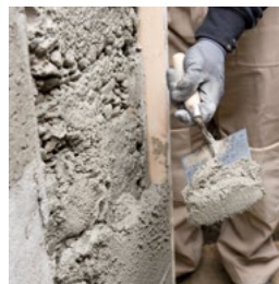
Neplaneitățile se nivelează cu Mortarele de reparații Repol .
