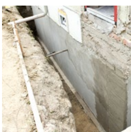
egalizare cu mortar mineral
