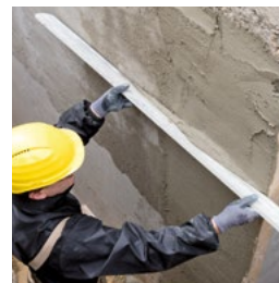
Nivelarea mortarului se face cu dreptarul.
